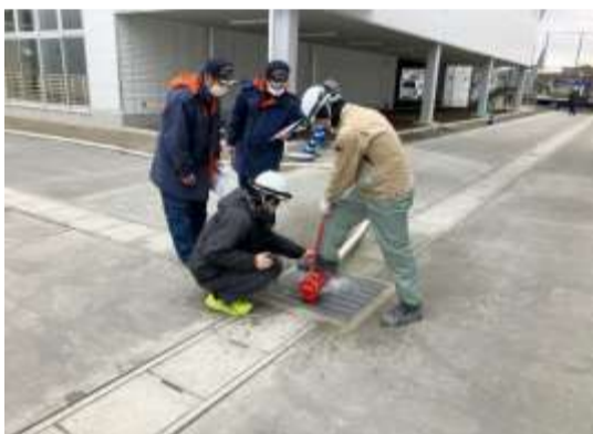
【消防検査】管轄の消防署で検査しました。
