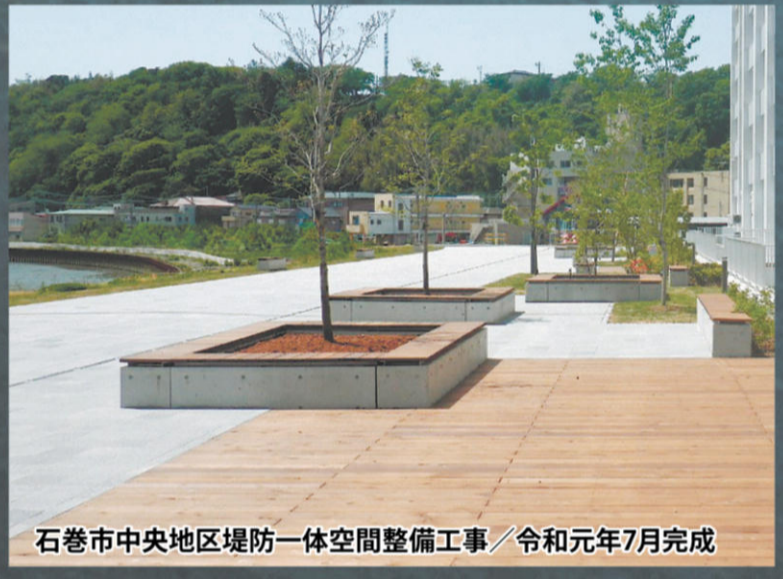
旧北上川右岸中央地区築堤工事/平成28年12月完成 東北地方整備局局長賞受賞 旧北上川右岸中央上流地区築堤工事/平成31年3月完成
