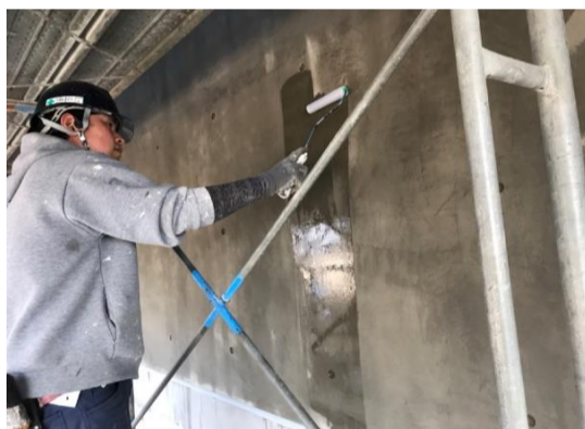
【管理棟】外壁の塗装工事を行っています。
