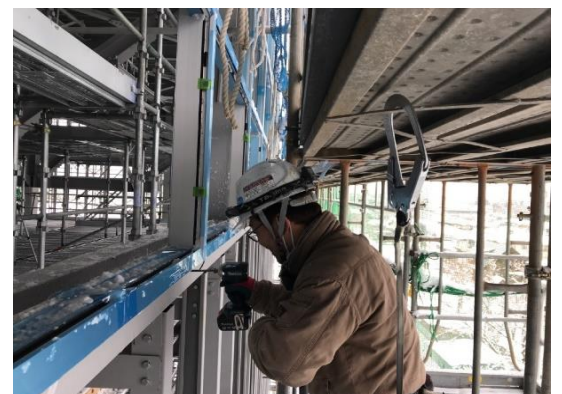
【体育館棟】外部のサッシの取付をしています。
