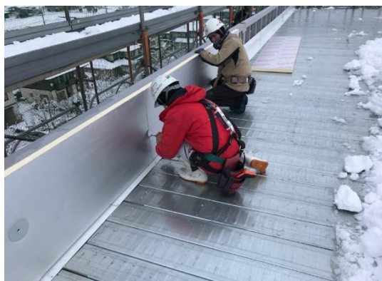
【体育館棟】屋上の防水工事が始まりました。断熱材を全面に敷きます。
