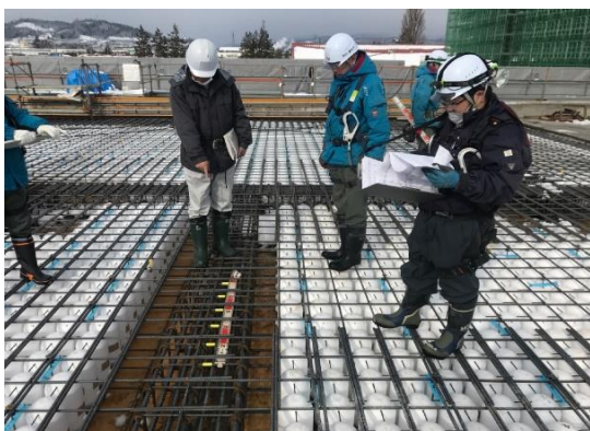
【校舎棟】躯体コンクリートの打設前は、監理者さんの検査を受けます。
