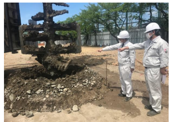
大きな攪拌翼で柱状の改良体を作ります。
