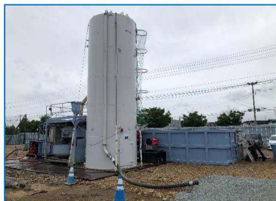
[改良用プラント] 手前の白いサイロに入っているセメント系固化材を毎日50tほど使用しています。
