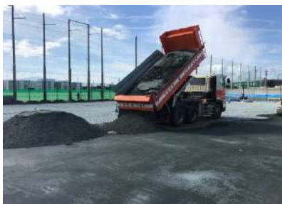
テニス、ハンドコートはボールの跳ね返りを良くするためグリーンサンドで仕上げます
