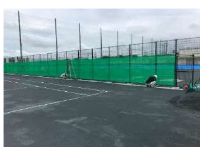
防球フェンスを設置し、防砂ネットを張ります
