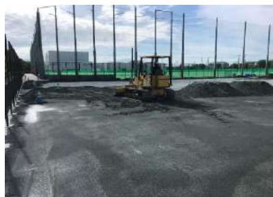
テニス、ハンドコートはボールの跳ね返りを良くするためグリーンサンドで仕上げます
