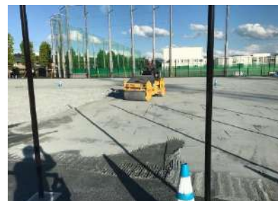
テニス、ハンドコートはボールの跳ね返りを良くするためグリーンサンドで仕上げます
