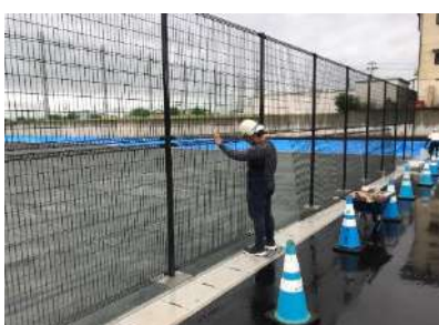
防球フェンスを設置し、防砂ネットを張ります
