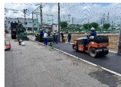
敷均した後、転圧して締固め
