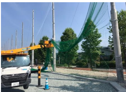
金物にワイヤーを張り、ワイヤーにネットを張り付けます
